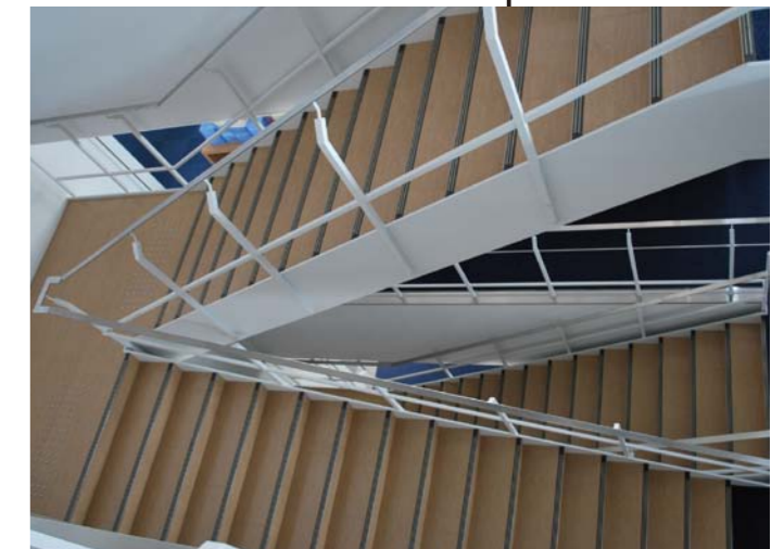
フロア間を結ぶ内階段。コミュニケーション促進の重要なアイテムになっている。
