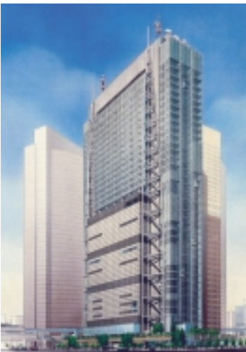
日本テレビ放送網新社屋完成予想図 平成15年4月竣工予定
