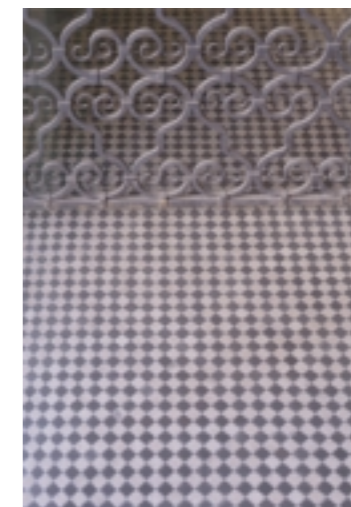
1階店舗の床は竣工当時のモザイクタイルが使われている
