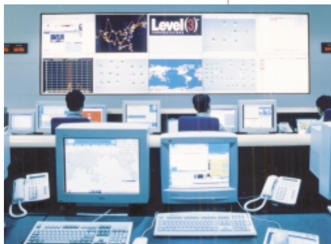
オペレーションルーム
