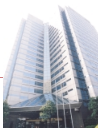
レベルスリー データセンター
