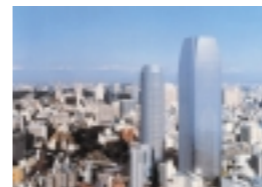
愛宕プロジェクト全景イメージ (竣工:2001年8月)
