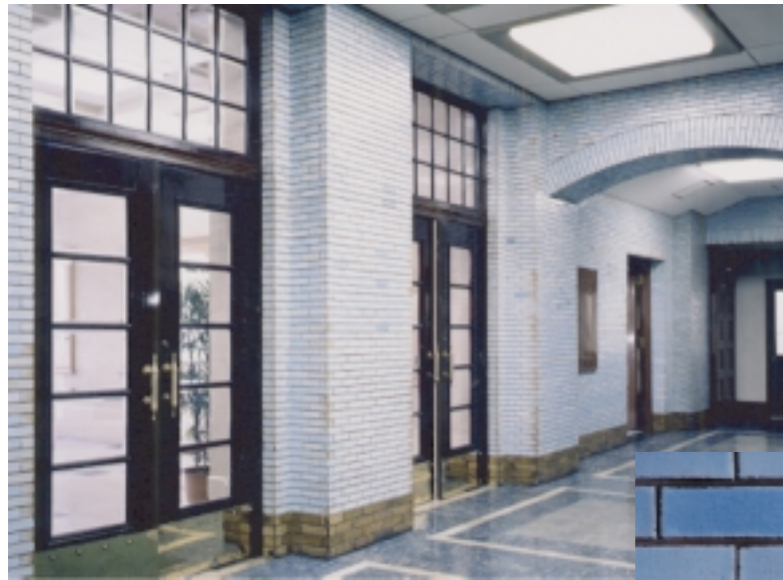
落ち着いた空間に仕上がっている1階エレベーターホールと建物を象徴する素材タイル。設計者である元早稲田大学工学部教授・佐藤功一が自ら製作・選定にこだわり、大阪や名古屋の工場まで幾度も赴いて、現場の技術者を指導したという
