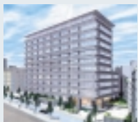
(仮)一番町東急プロジェクト 千代田区一番町 2002年10月 地上11階地下1階
