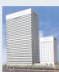
(仮)汐留浜離宮サイドプロジェクト 港区東新橋 2005年3月 地上38階地下3階
