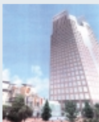
(仮)飯田橋計画 千代田区飯田橋 2003年3月 地上35階
