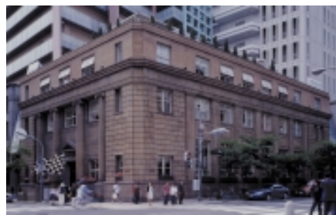
リブラプウエスト(旧居留地38番館)昭和4年竣工の石積で造られた重厚で量感のある建物である。現在は、内部を改装し、ブティックなどの店舗が多数入居している
