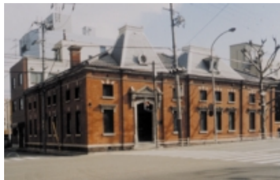
石川ビル(旧東京倉庫兵庫出張所)明治38年の竣工。ドーマー窓や煉瓦煙突など、調和のとれた建物の仕上っている
