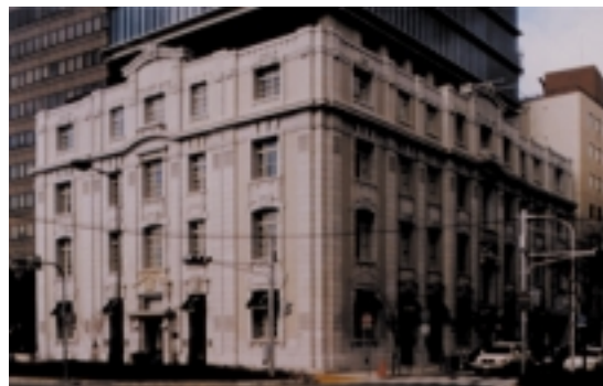
海岸ビル(旧三井物産神戸支店)カーン式という特殊な工法で構築された。大正8年の竣工。外壁は、震災による再建で元の石材を再利用するかたちで復元保存されている
