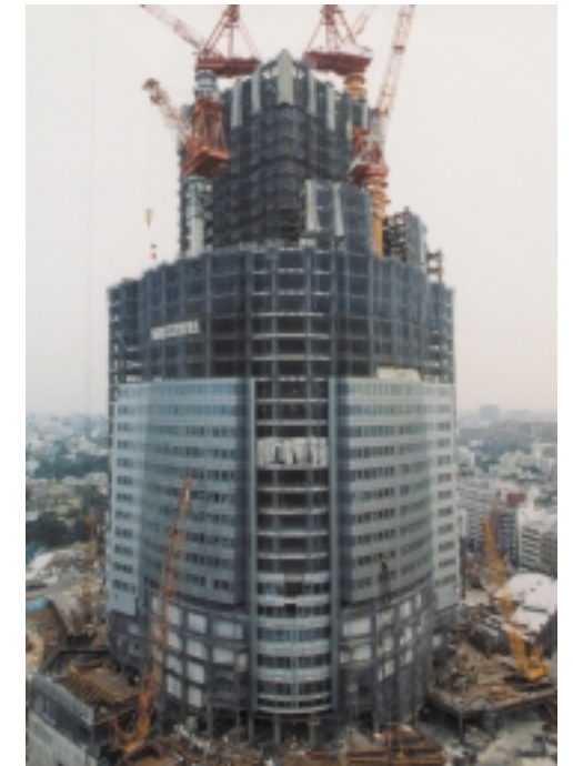
現在の六本木ヒルズの工事写真(2001年9月撮影)
