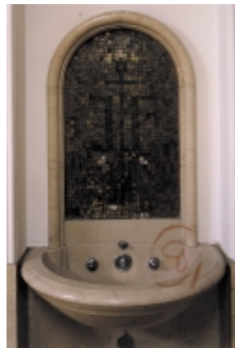
エレベーターホールの両脇に設けられた洗面台。残念ながら現在は使うことができない
