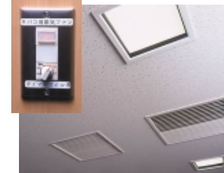
喫煙スペース上に設置。煙草の煙をビルの外に直接排気するシステムで、排気設備を強化しているため、非喫煙者からの苦情はでていない
