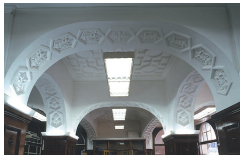
現在の1階フロア天井。竣工当時と変わっていない
