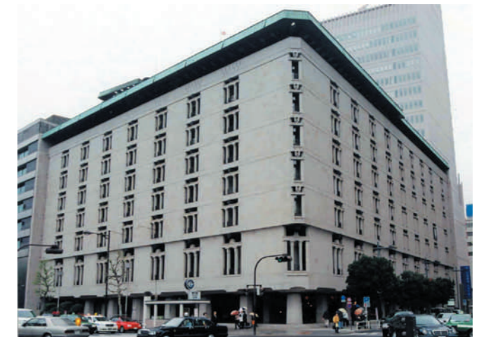
現在の日本生命日比谷ビル全景
