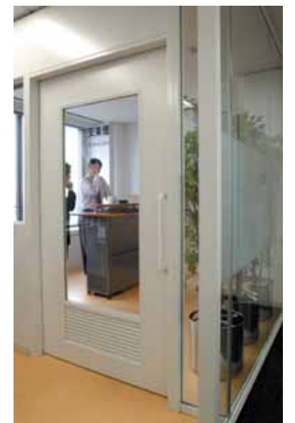
喫煙ルーム(交楽煙)。 強制排気を行っているため煙草の臭いは ほとんど感じない
