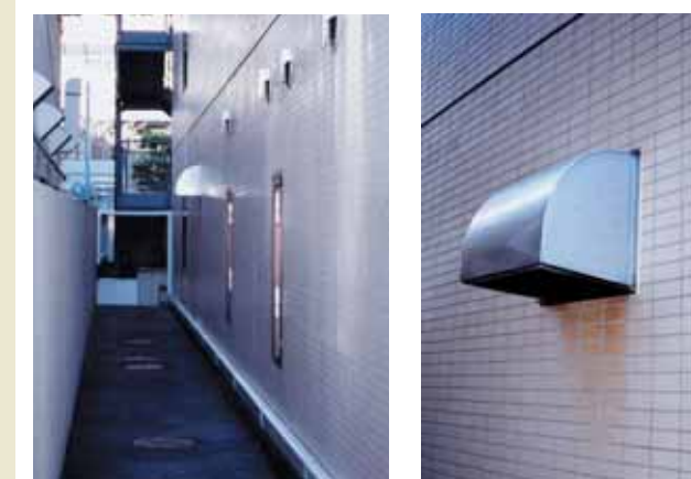
新設した換気口
