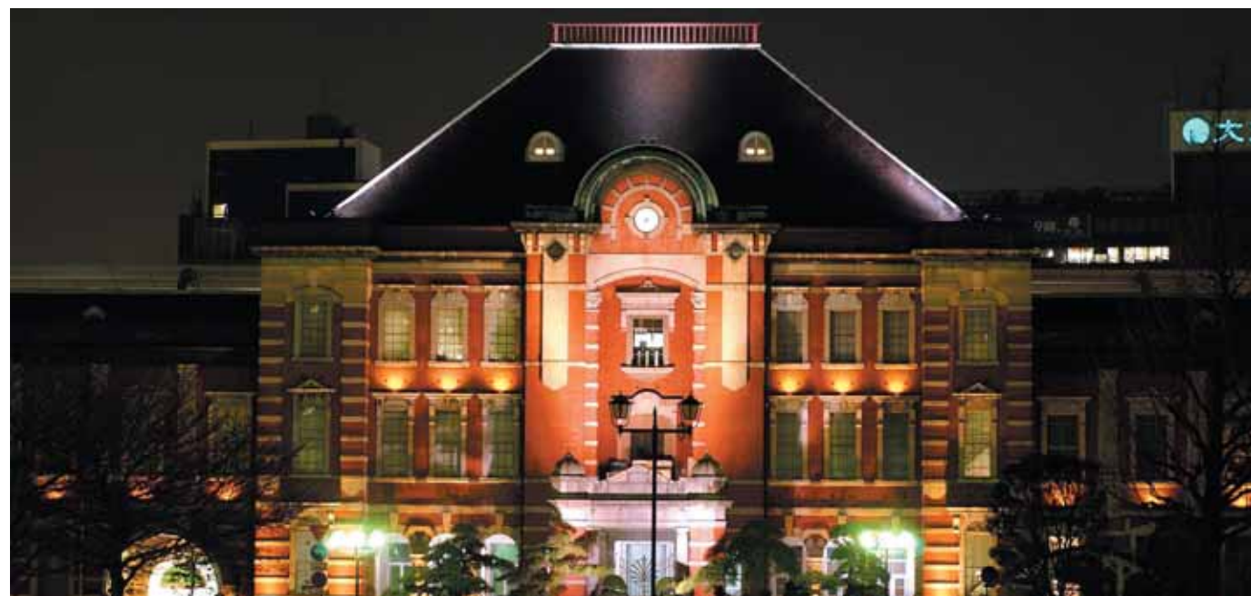
(上)ステーションホテル中央入口、(下)ライトアップされ重厚な意匠を一層引き立たせた東京駅正面
