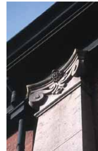
正面入口上部の外壁
